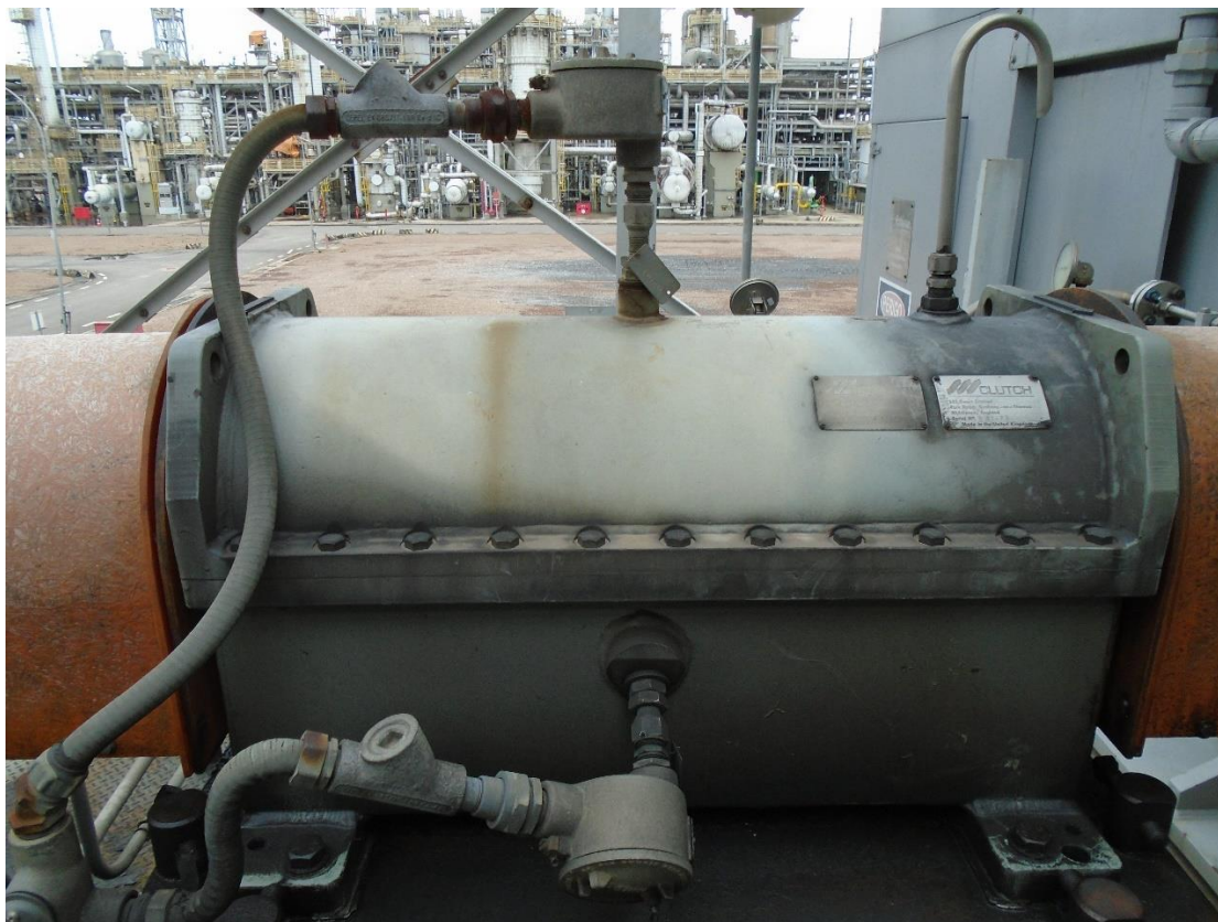
Figura 37: Embreagem Encapsulada SSS Clutch
